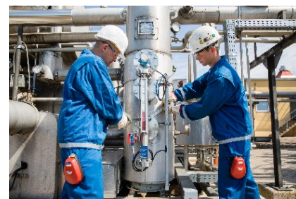
Arbeiten an der Anlage zur Sauergasförderung auf dem Gelände in Staffhorst.
