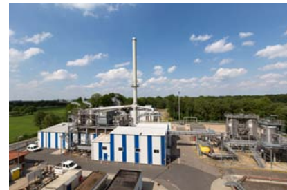
Die Dampfflutanlage in Emlichheim produziert heißen Dampf, der in der Lagerstätte das Erdöl leichter förderbar macht.
